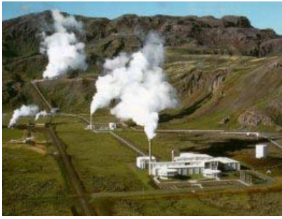
Central geomètrica (Islàndia)
